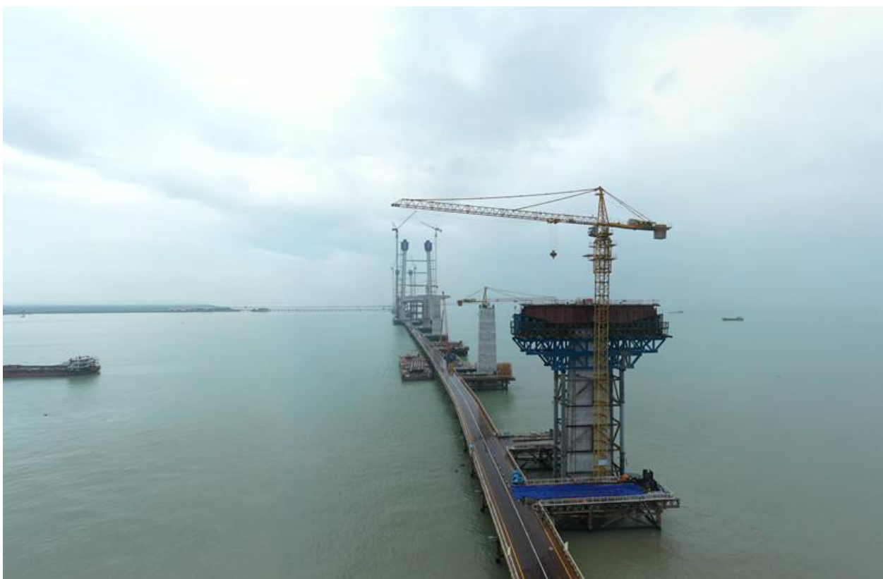
建设中的深中通道
