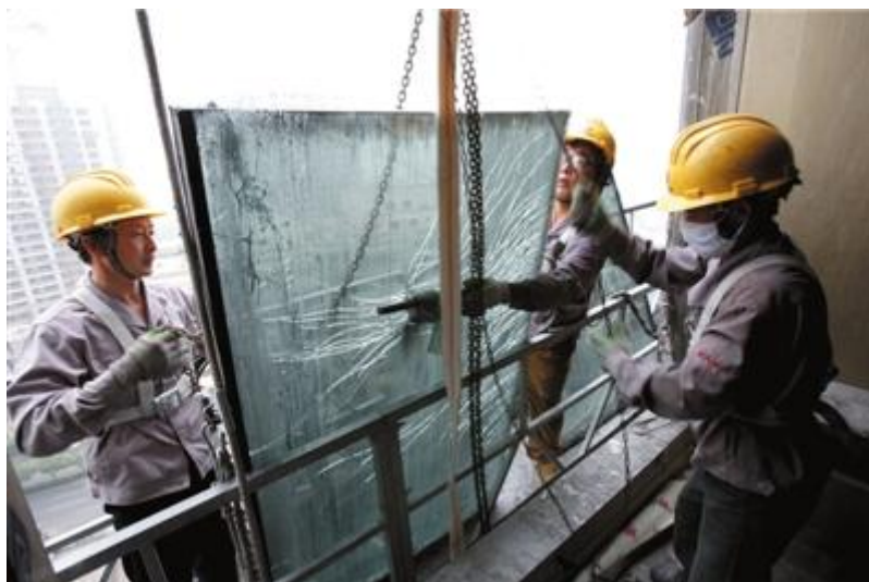
工人们在为启动拆卸复建做准备。城建集团供图
