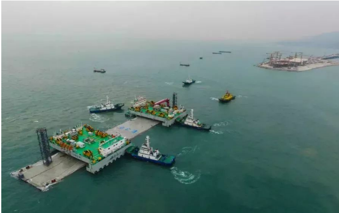
E30 沉管到达施工海域
