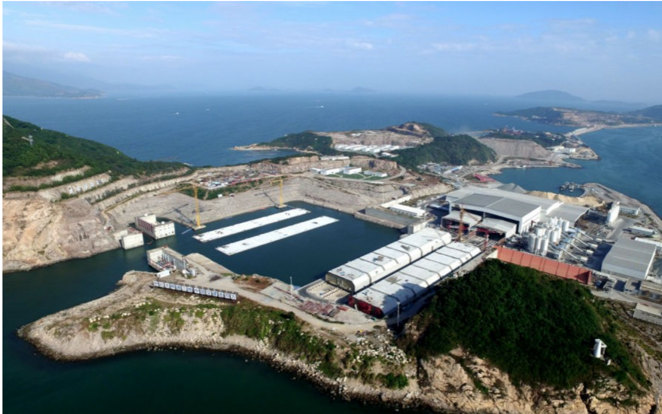
沉管预制工厂全景
