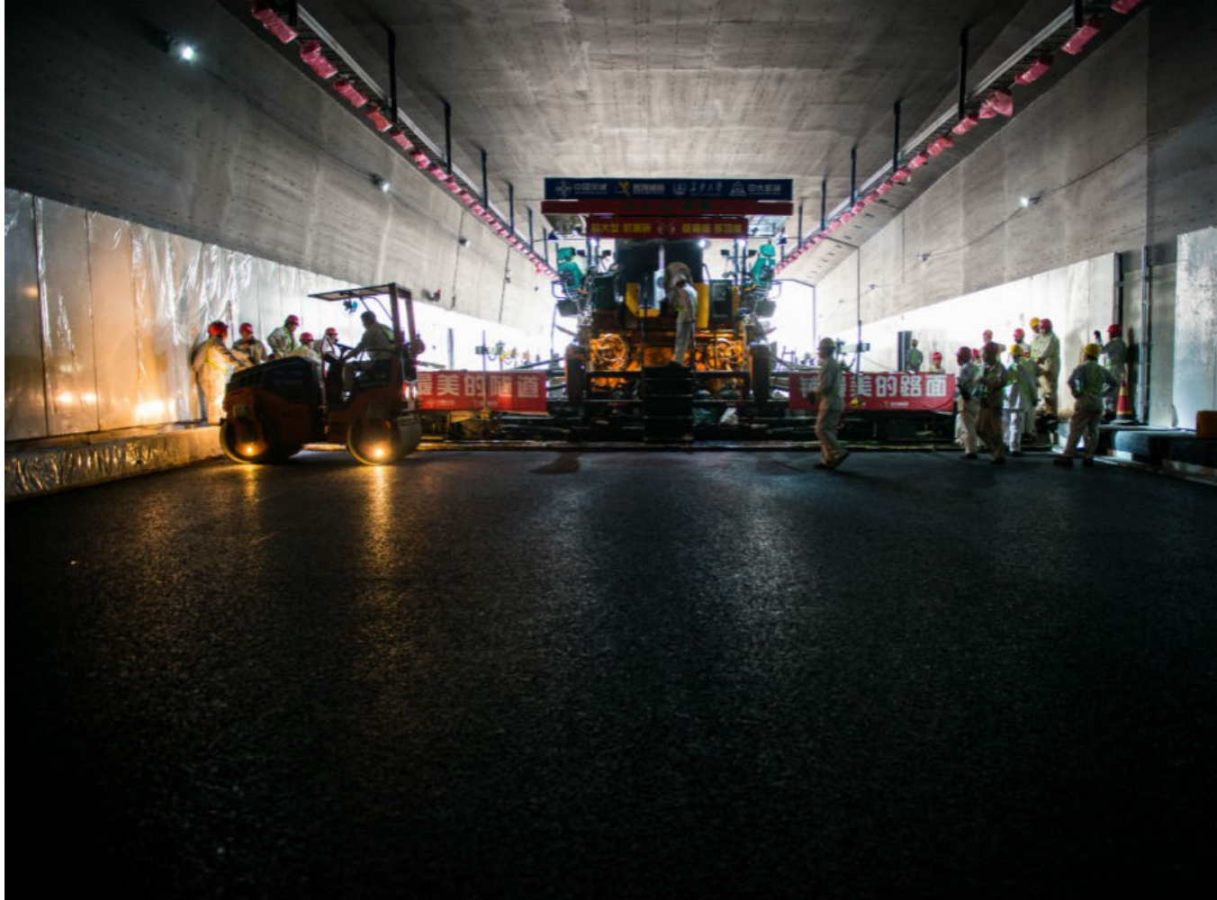
正在沉管隧道里作业的中大机械可动态变换宽度的 DT2000 摊铺机
