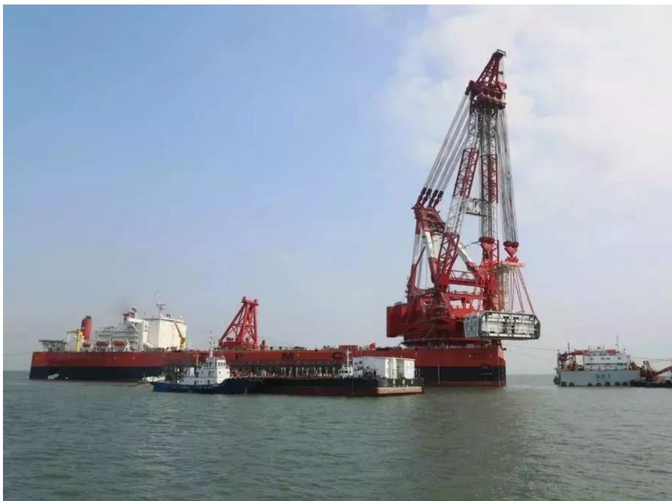
港珠澳大桥沉管隧道Z终接头吊装
