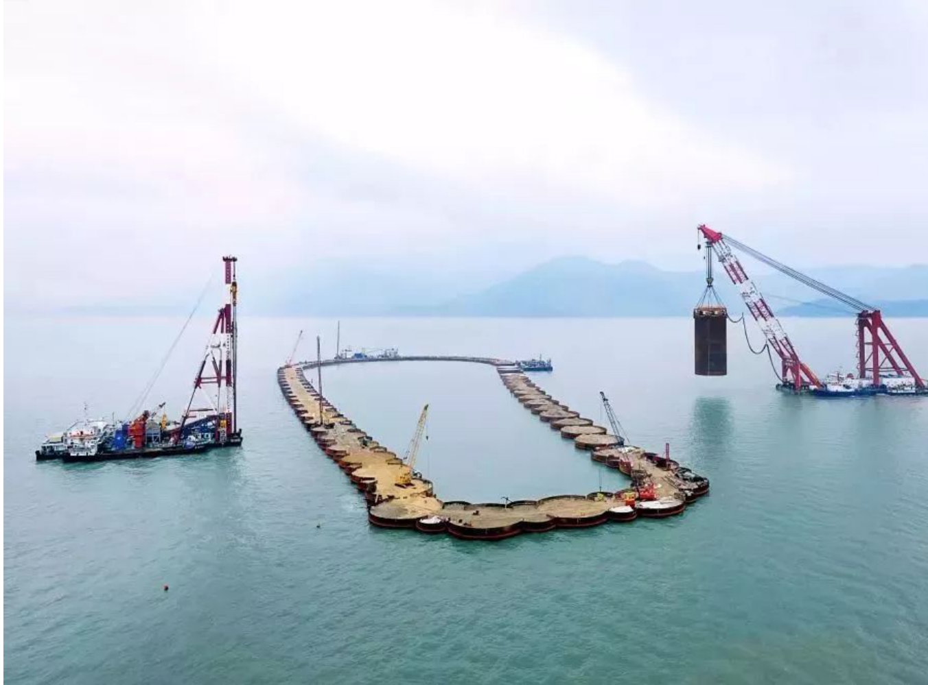
东人工岛最后一根钢圆筒安装 朱宇光 摄
